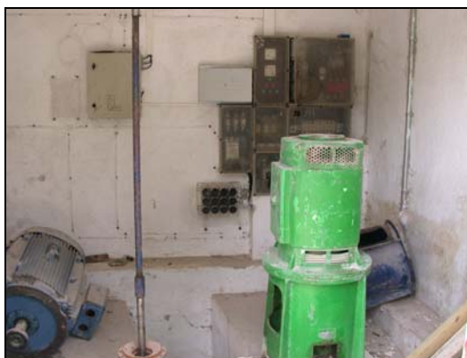
Instalación Sondeo I
