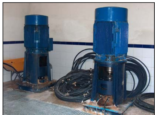
Instalación Sondeo II
